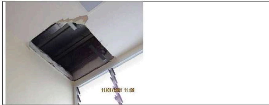
SALA DE INALAÇÃO: Problemas no teto, infiltração e goteira.
