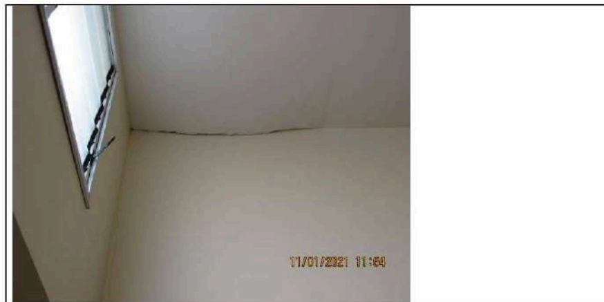
SALA DE INALAÇÃO: Problemas no teto, infiltração e goteira.
