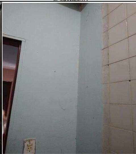
FOTO 23- PAREDE BANHEIRO INTERNO SEM CERÂMICA
