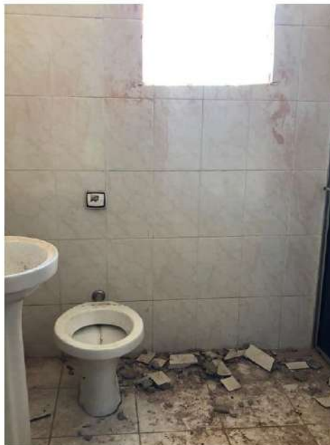
FOTO 24 – BANHEIRO DA SUÍTE DO PAVIMENTO SUPERIOR
