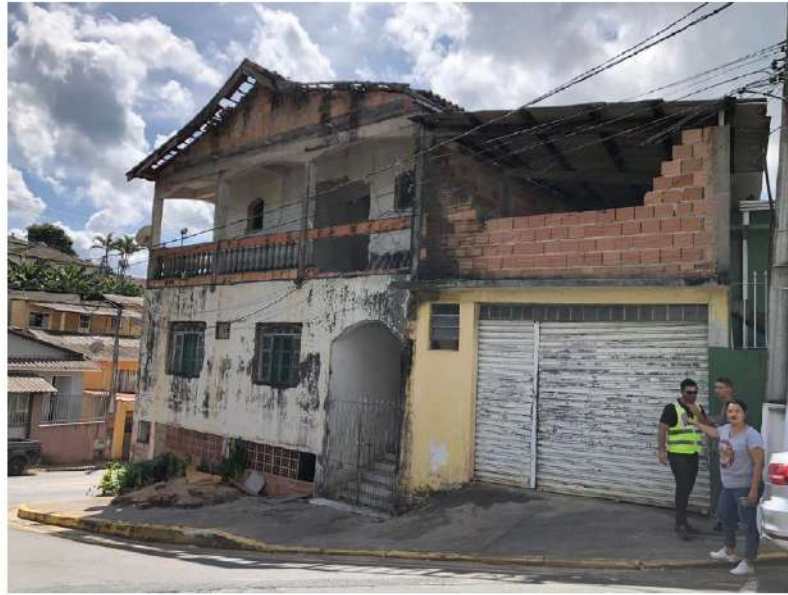
FOTO 01 – FACHADA RUA IRMÃ CARMELA TESSAROLI
