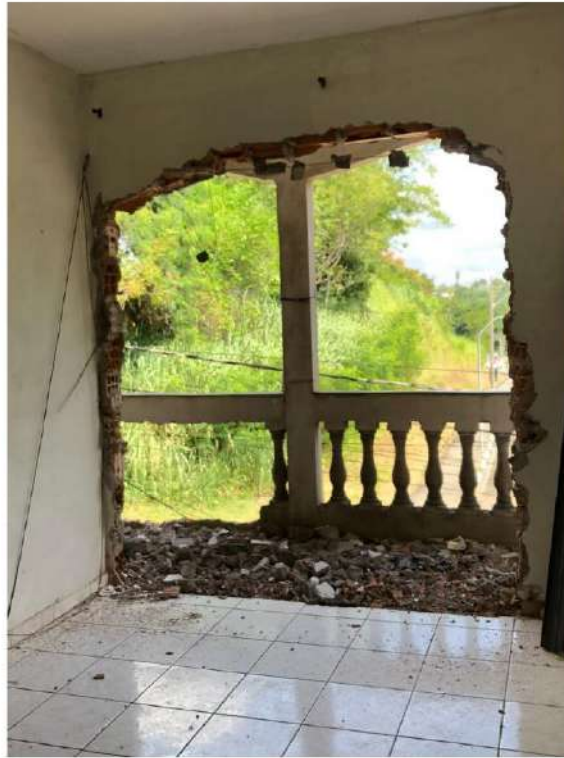
FOTO 23 – DETALHE DA SALA DE ESTAR DO PAVIMENTO SUPERIOR ONDE FOI RETIRADO UMA PORTA DE AÇO
