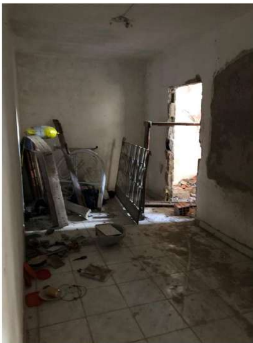
FOTO 48 – SALA 02 DO PAVIMENTO INFERIOR
