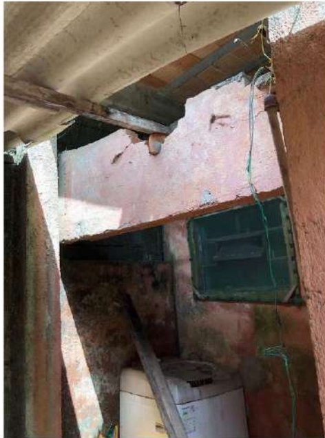
FOTO 39 – DETALHE DA ESTRUTURA NO PAVIMENTO INFERIOR
