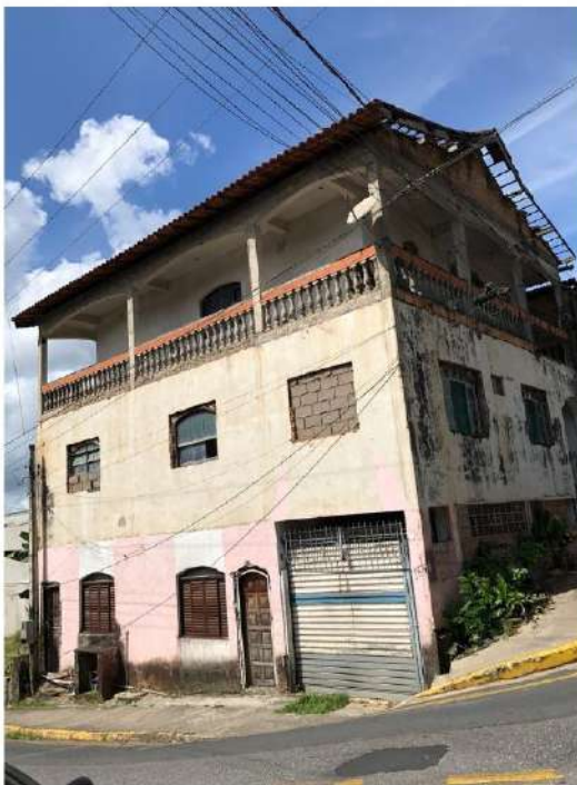
FOTO 03 – FACHADA – RUA TEODORO FERREIRA MACHADO
