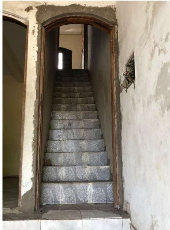
FOTO 19 – ESCADA DE ACESSO AO PAVIMENTO SUPERIOR
