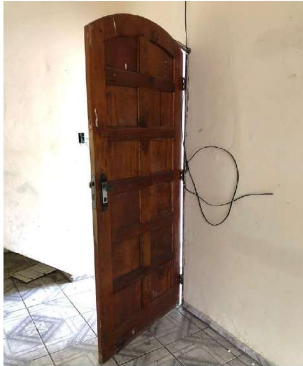
FOTO 11 – DETALHE DA PORTA DE ACESSO DO PAVIMENTO TÉRREO
