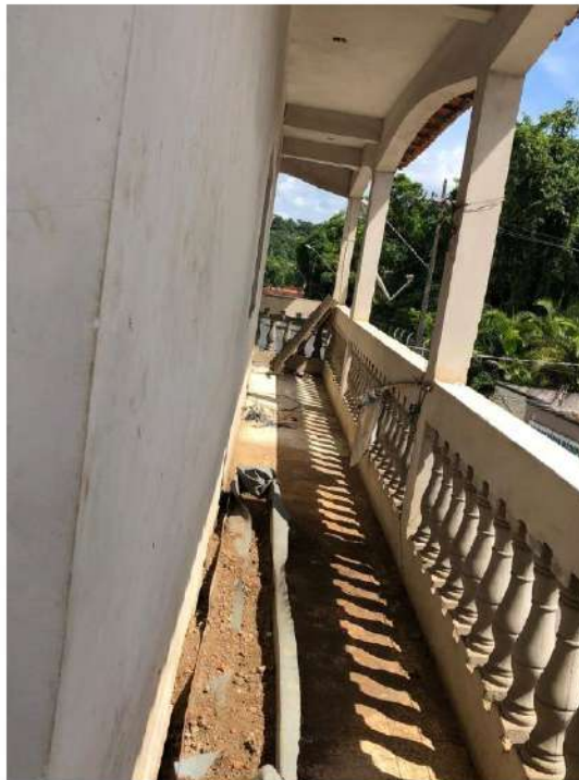
FOTO 33 – VARANDA DO PAVIMENTO SUPERIOR (FACHADA NORTE)
