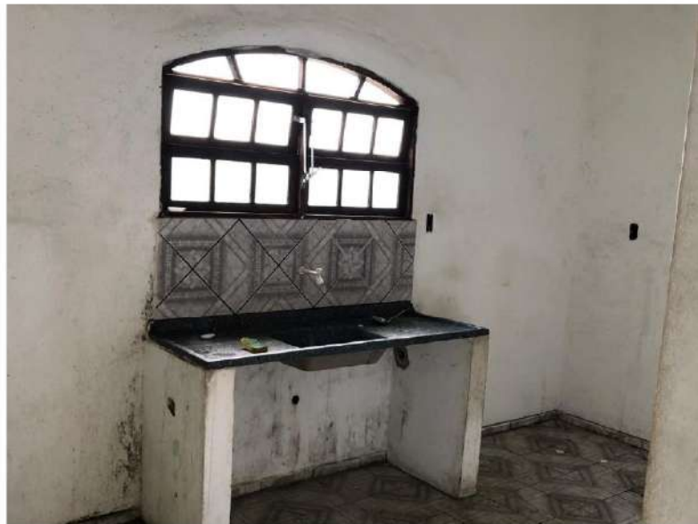
FOTO 12 – COZINHA DO PAVIMENTO TÉRREO
