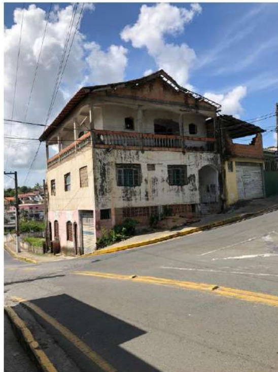
FOTO 02 – FOTO AMPLA DA FACHADA
