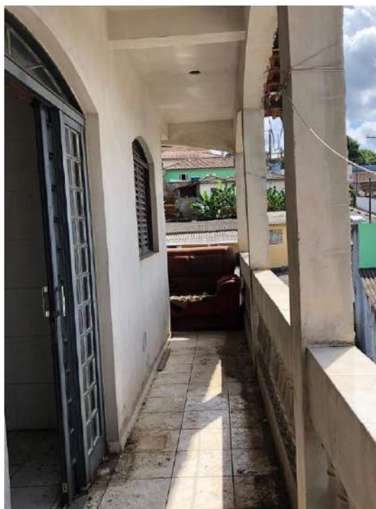
FOTO 32 – VARANDA DO PAVIMENTO SUPERIOR (FACHADA LESTE)
