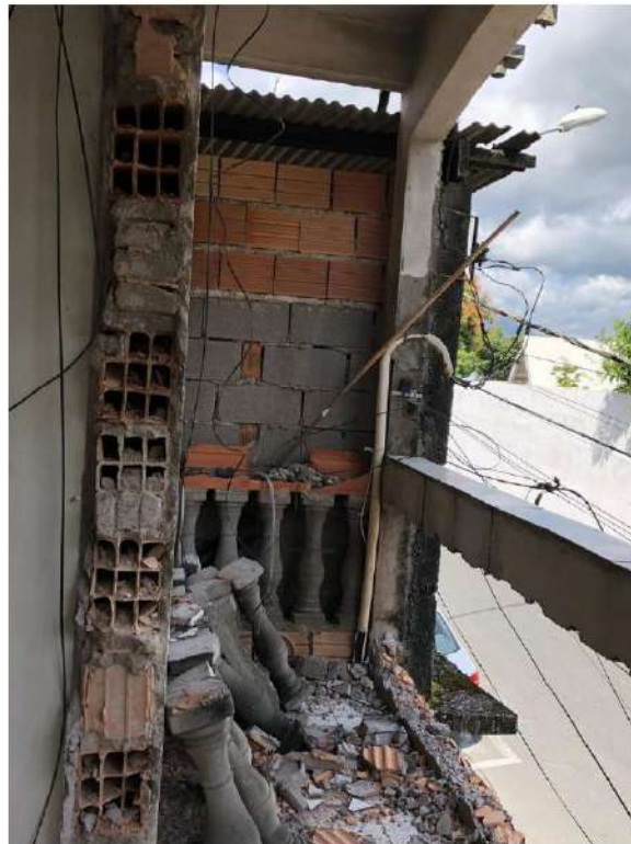
FOTO 30 – VARANDA DO PAVIMENTO SUPERIOR (FACHADA OESTE)
