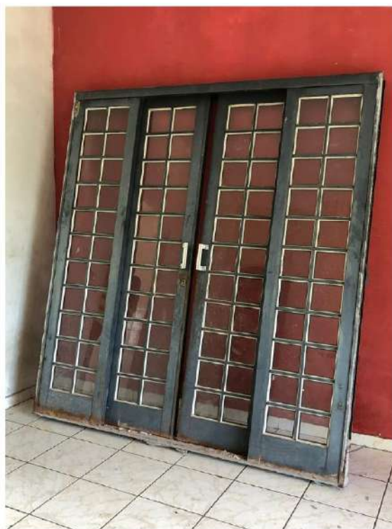
FOTO 22 – PORTA DE AÇO RETIRADA DA SALA DE ESTAR DO PAVIMENTO SUPERIOR
