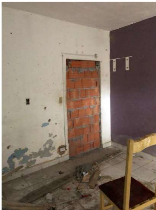
FOTO 47 – SALA 01 DO PAVIMENTO INFERIOR
