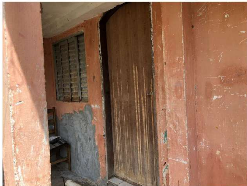
FOTO 38 – PORTA DE ACESSO PELA FACHADA SUL AO PAVIMENTO INFERIOR
