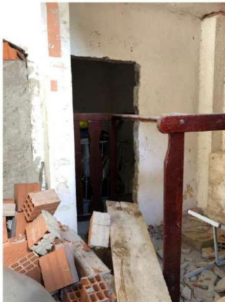
FOTO 50 – ABERTURA ENTRE A GARAGEM E SALA 02 DO PAVIMENTO INFERIOR
