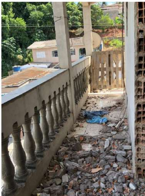
FOTO 31 – VARANDA DO PAVIMENTO SUPERIOR (FACHADA OESTE)
