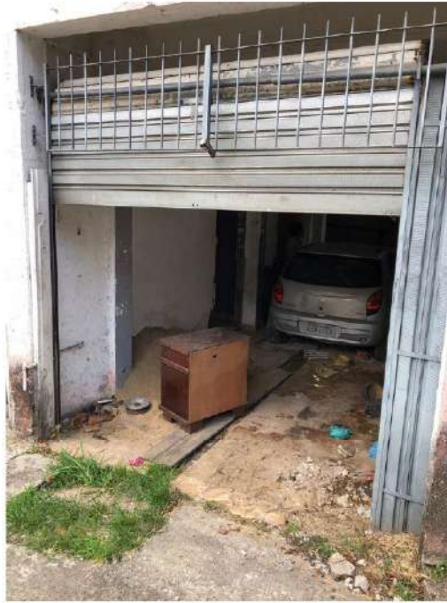
FOTO 45 – PORTA DE ACESSO À GARAGEM DO PAVIMENTO INFERIOR
