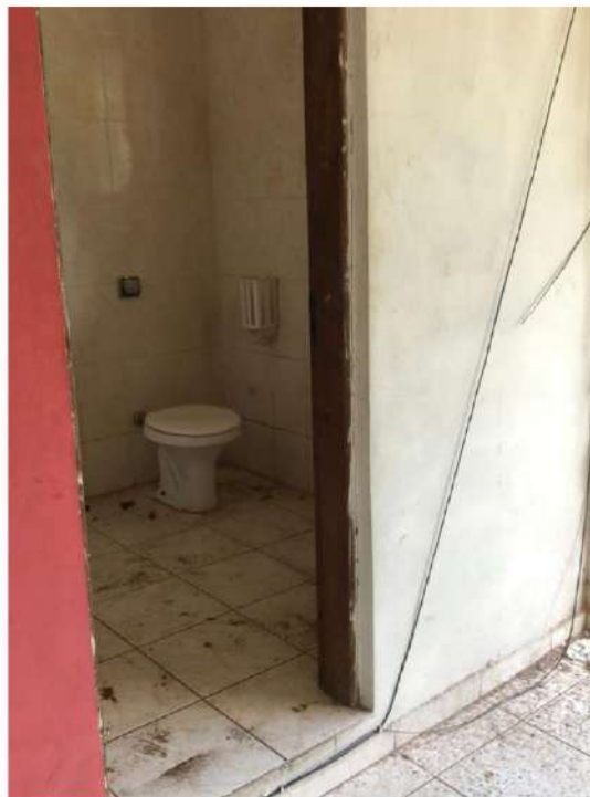
FOTO 27 – BANHEIRO SOCIAL DO PAVIMENTO SUPERIOR
