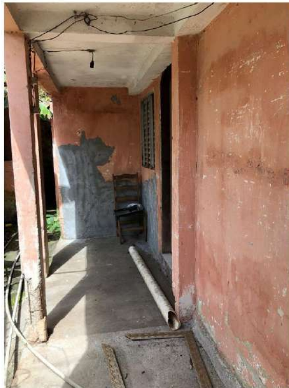
FOTO 40 – ÁREA DE ACESSO PELA FACHADA SUL AO PAVIMENTO INFERIOR
