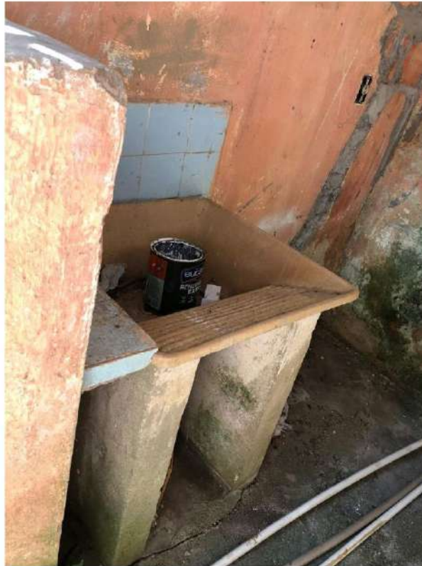
FOTO 37 – DETALHE DO TANQUE DA ÁREA DE SERVIÇO DO PAVIMENTO INFERIOR
