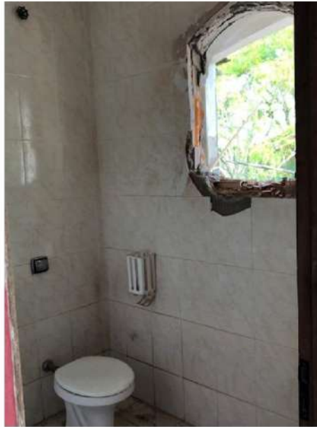
FOTO 29 – ABERTURA DA JANELA DO BANHEIRO SOCIAL DO PAVIMENTO SUPERIOR
