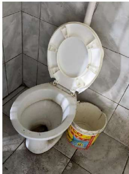
FOTO 16 – DETALHE DO SANITÁRIO DO PAVIMENTO TÉRREO
