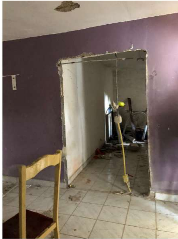
FOTO 49 – ACESSO A SALA 02 DO PAVIMENTO INFERIOR
