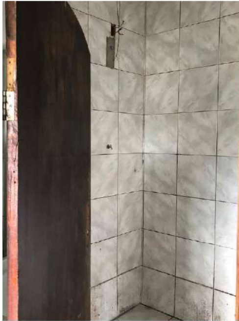
FOTO 17 – DETALHE DA ÁREA DE BANHO
