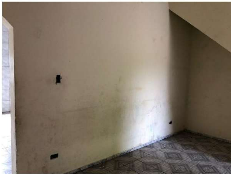
FOTO 08 – SALA DE ESTAR DO PAVIMENTO TÉRREO
