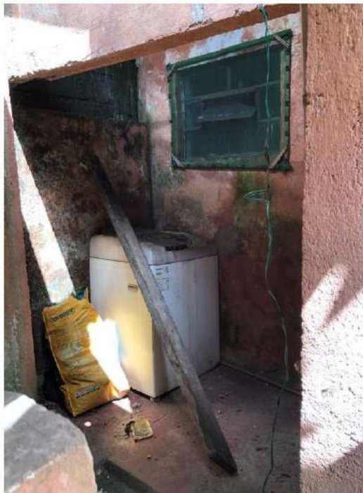
FOTO 36 – ÁREA DE SERVIÇO DO PAVIMENTO INFERIOR
