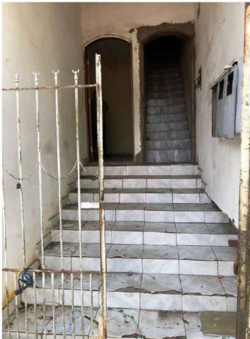
FOTO 06 – PORTAS DE ACESSO AO PAVIMENTO TÉRREO E SUPERIOR
