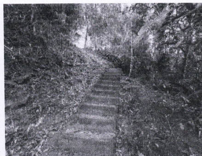
b) Acesso a ponte através de escadaria.
