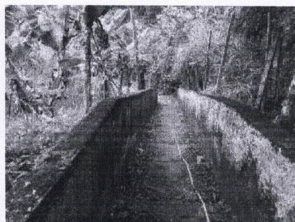
b) Acesso a ponte através de escadaria.
