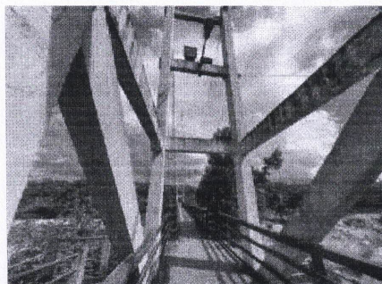
c) Estrutura de sustentação da ponte.
