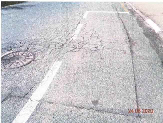
Foto 04 – Trinca couro de Jacaré – estão associadas à repetição das cargas de tráfego (concentram-se nas trilhas da roda)
