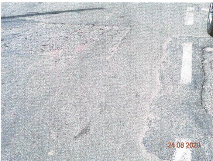
Foto 11 – Remendo: panela preenchida com uma ou mais camadas de pavimento na operação denominada “Tapa Buraco”
