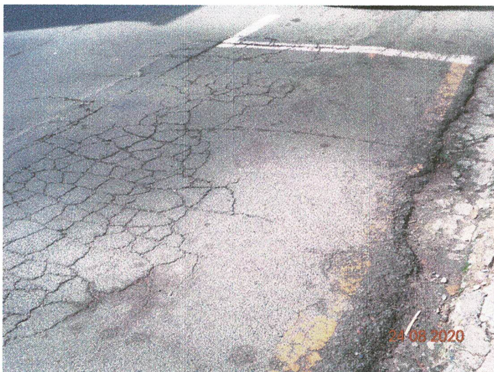
Foto 10 – Trinca couro de Jacaré – estão associadas à repetição das cargas de tráfego (concentram-se nas trilhas da roda)
