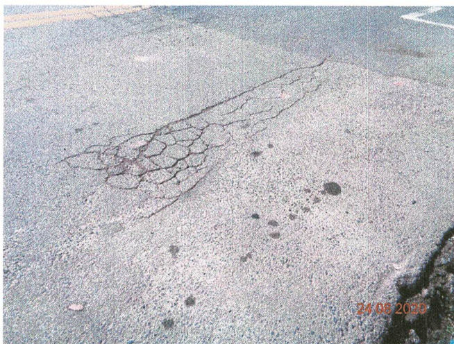
Foto01 – Trinca couro de Jacaré – estão associadas à repetição das cargas de tráfego (concentram-se nas trilhas da roda)
