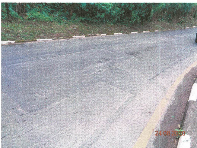
Foto 08 – Remendo: panela preenchida com uma ou mais camadas de pavimento na operação denominada “Tapa Buraco”
