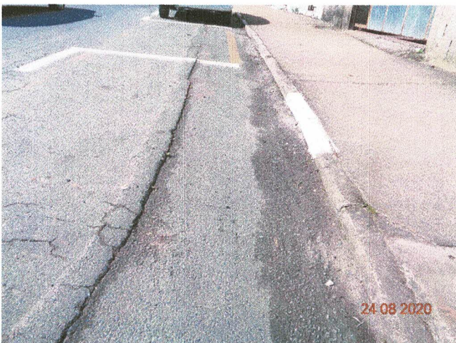
Foto 05 – Remendo: panela preenchida com uma ou mais camadas de pavimento na operação denominada “Tapa Buraco”
