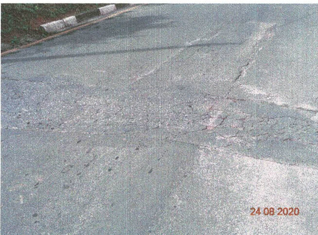
Foto 12 – Remendo: panela preenchida com uma ou mais camadas de pavimento na operação denominada “Tapa Buraco”
