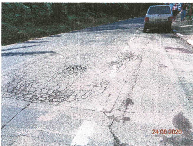
Foto 07 – Remendo: panela preenchida com uma ou mais camadas de pavimento na operação denominada “Tapa Buraco”
