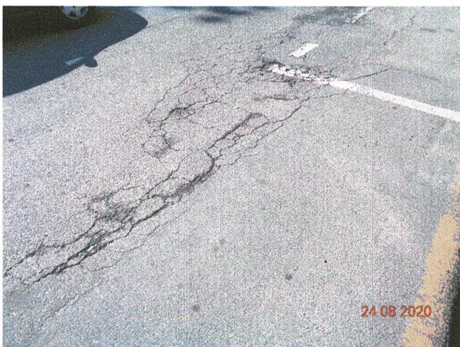
Foto 02 – Trinca couro de Jacaré – estão associadas à repetição das cargas de tráfego (concentram-se nas trilhas da roda)
