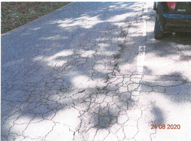
Foto 03 – Trinca couro de Jacaré – estão associadas à repetição das cargas de tráfego (concentram-se nas trilhas da roda)
