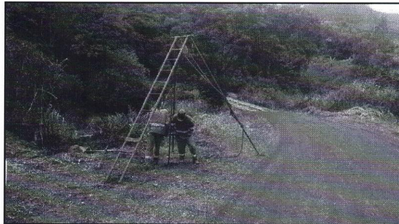
Imagem 01 – Execução da Sondagem
