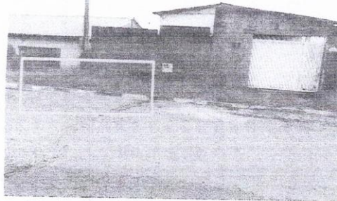
c) Local recomendado para execução da boca de lobo. Residência da Requerente localizada logo a esquerda.
