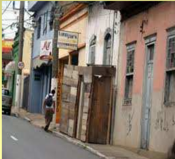
Incorreto: tapumes ocupando toda calçada.
