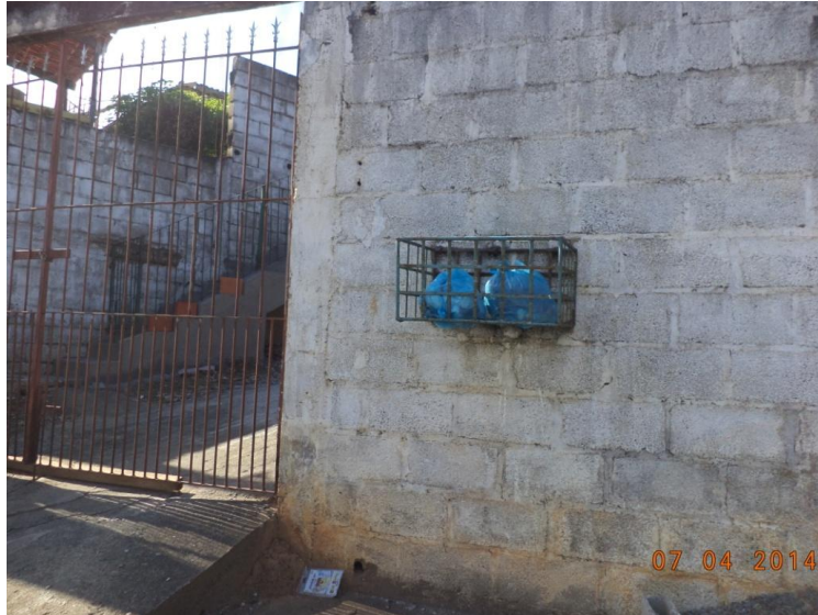
Figura 13 – Acondicionamento de Resíduos em Lixeiras Próprias e Distantes do Chão
