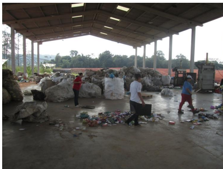
Figura 21 – Vista geral do galpão aberto.
