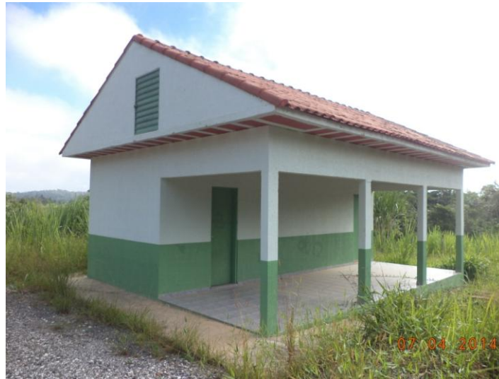
Figura 17 – Casa para guarda de material e descanso dos trabalhadores do aterro.
