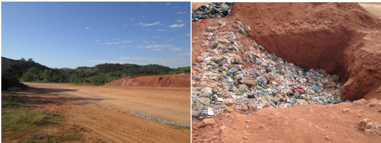
Figura 15 – Visão geral do aterro controlado de Cajati.
