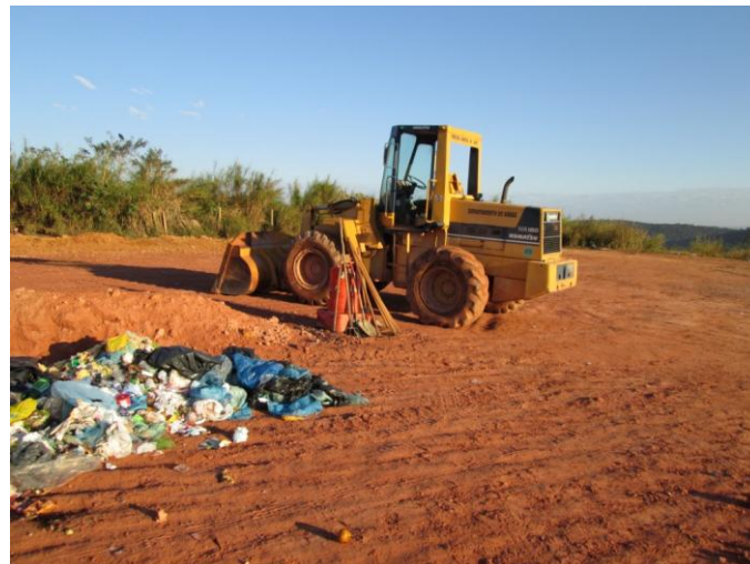
Figura 18 – Pá carregadeira utilizada para o recobrimento dos resíduos.
