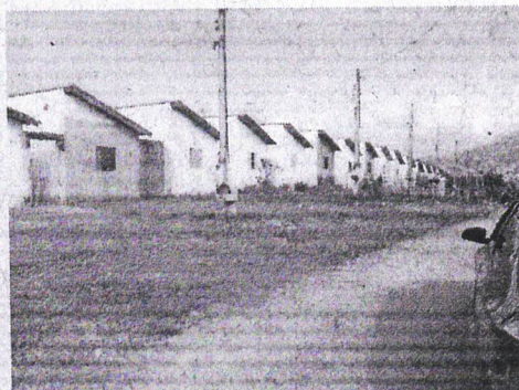
Ilustração 5 Conjunto habitacional da Caixa
