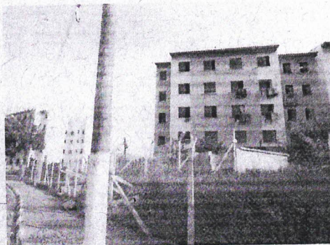
Figura 13 Conjunto Habitacional em Cajati
